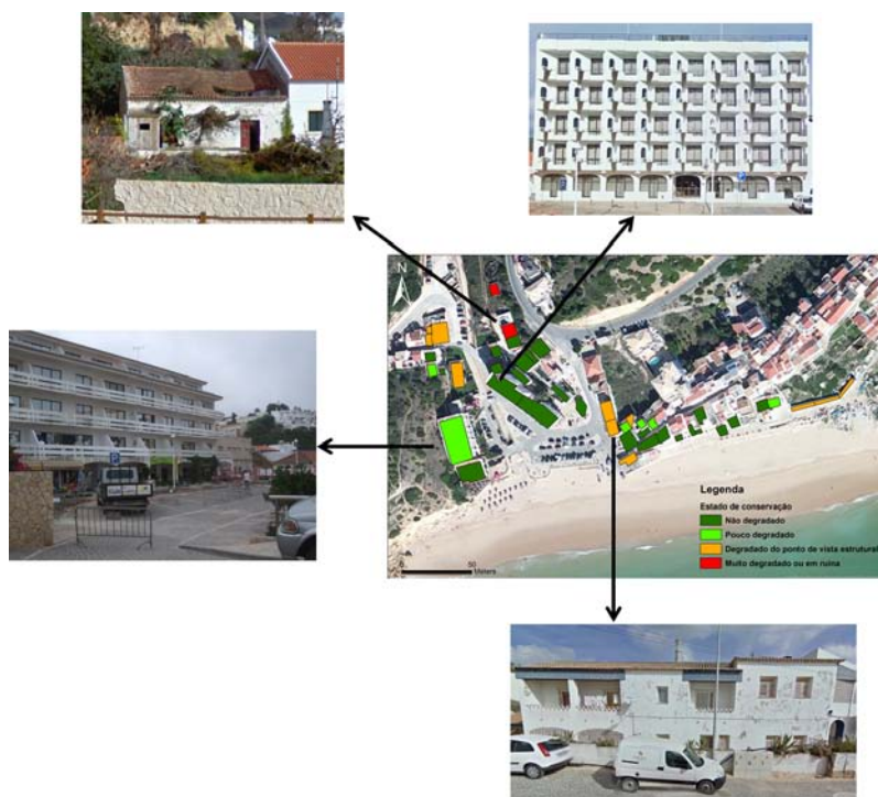
Figura 3 – Representação do estado de conservação dos edifícios a partir de dados recolhidos com a aplicação Collector for ArcGIS ® instalada em dispositivo móvel (Projeto TSURIMA).
