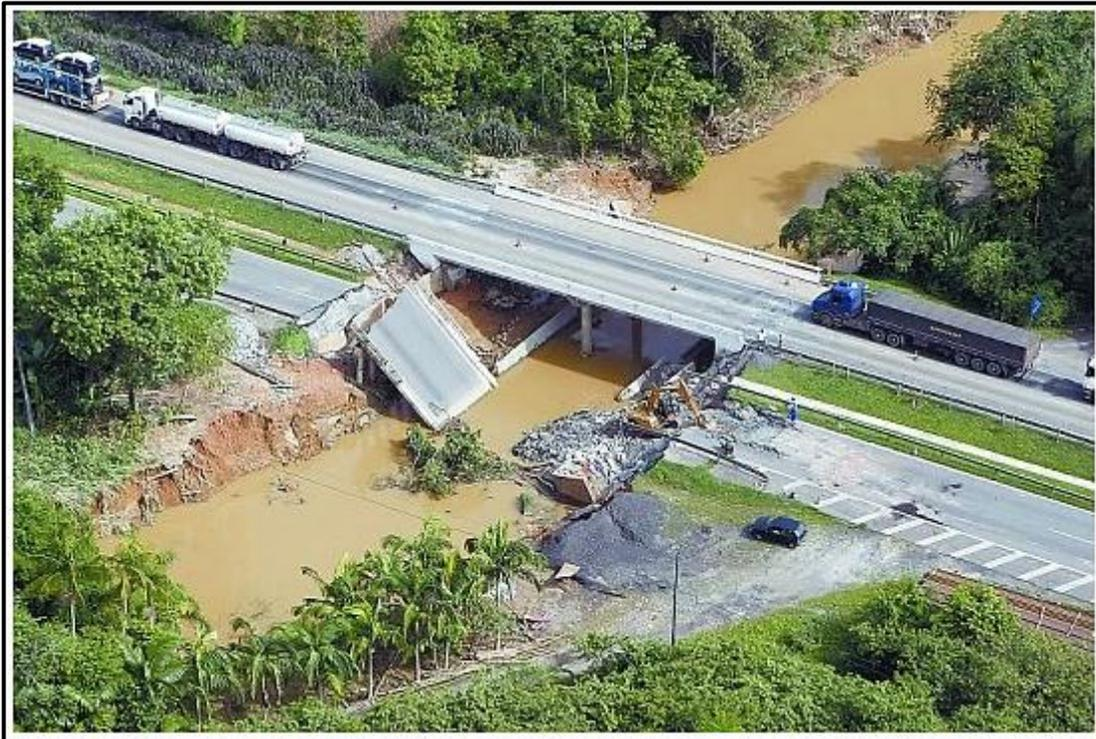
Figura 2: Destruição pela passagem de detritos decorrentes do evento de movimentos complexos ocorrido a montante. Uma das pontes sobre o Rio Jacareí na rodovia BR 277, principal via de acesso ao porto de Paranaguá, corredor de exportação internacional que atende no Brasil o Estado do Paraná e parte da Região Sul e Região do Pantanal mato-grossense além do Paraguai.
