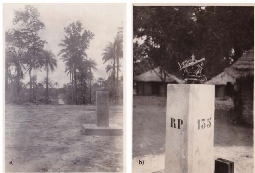
Figura 2 - Demarcação da fronteira: a) corredor de fronteira entre os marcos 127 e 128; b) marco 135 com teodolito Otto Fennel (Zilhão, 1930a)
